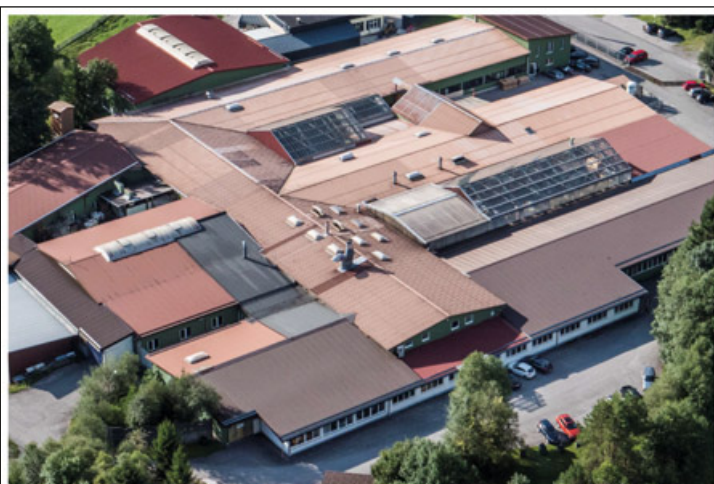
Foto: Urban Maschinenbau
