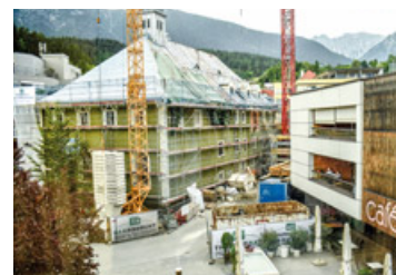
Der Platz rund um das Pflegezentrum in Imst ist derzeit eine Großbaustelle. Ab Herbst 2023 werden im modernen Altenwohnheim bis zu 120 Menschen ihren Lebensabend genießen. Foto: Eiter
