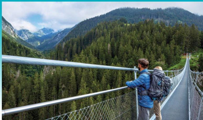
Die 200 Meter lange und 100 Meter hohe Holzgauer Hängebrücke überspannt die wildromantische Höhenbachtalschlucht und zählt zu den spektakulärsten Abschnitten des Lechwegs im Tiroler Lechtal.
