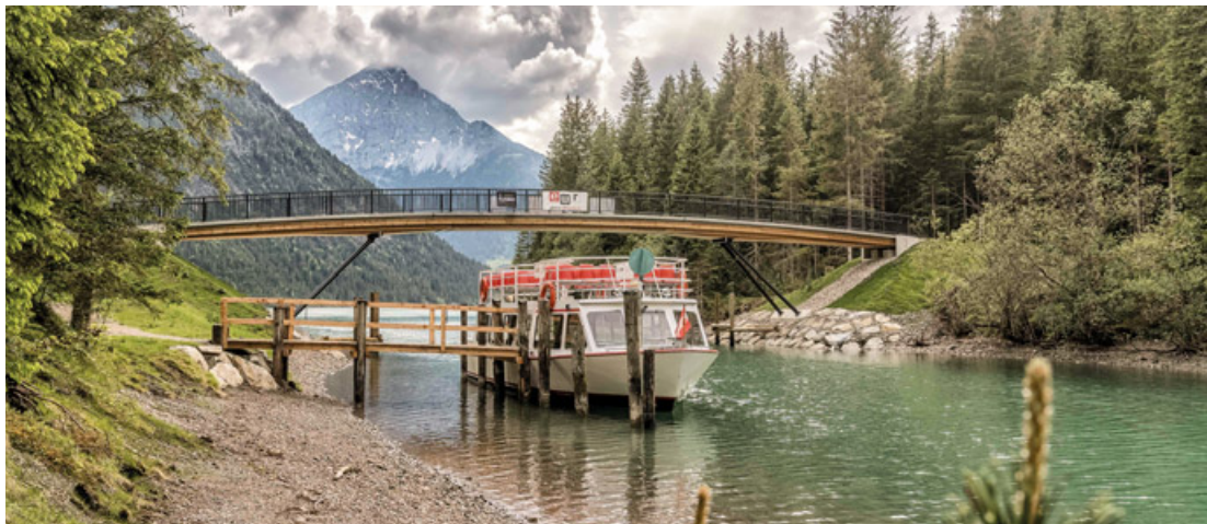
Die neue Rad- und Fußgängerbrücke überspannt den Kanal zwischen Plan- und Heiterwangersee.
