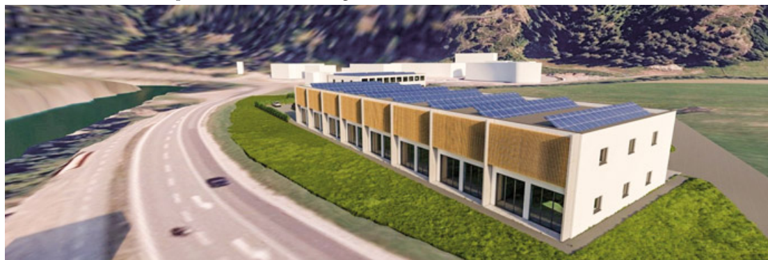
Derzeit wird der neue Gewerbepark erschlossen.
