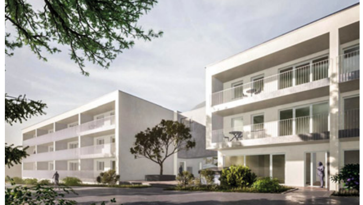
Der Baustart für das 30 Wohneinheiten umfassende Bauprojekt der Wohnungseigentümer ist bereits erfolgt.
