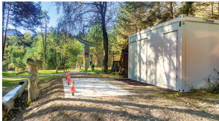
Die stark frequentierte WC-Anlage am Radweg in der Rease wurde komplett erneuert und wird in den nächsten Wochen ein Flugdach erhalten. Foto: Mayr
