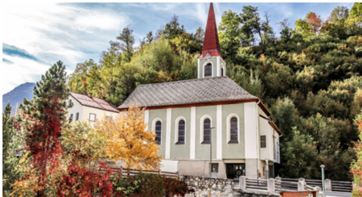
Der Vorplatz der Pfarrkirche sollte noch in diesem Jahr saniert werden.
