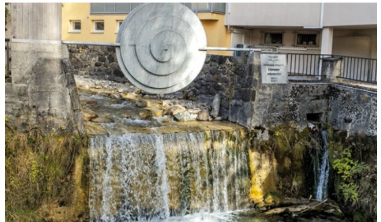
Idyllisch, aber nicht ungefährlich. Der Malchbach zwischen der Johanneskirche und dem Stadtwerkegebäude könnte bei Hochwasser aber verheerende Schäden anrichten.
