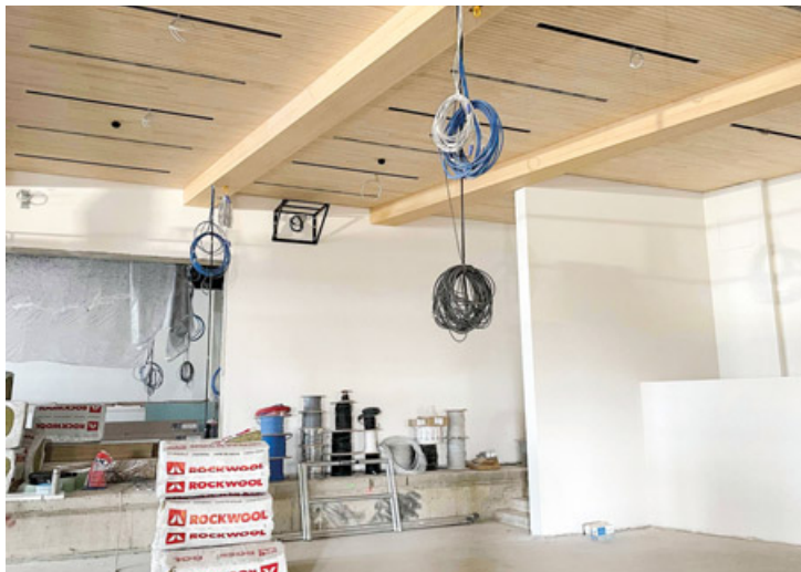
Im Zugspitzsaal in Ehrwald sind derzeit Bauarbeiten im Gang.
