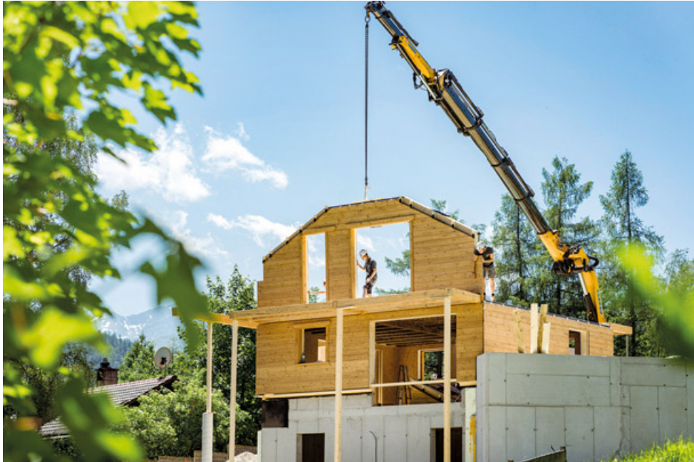
Wie Bauklötze werden die fertigen Elemente auf der unteren Geschossdecke aufgestellt.
