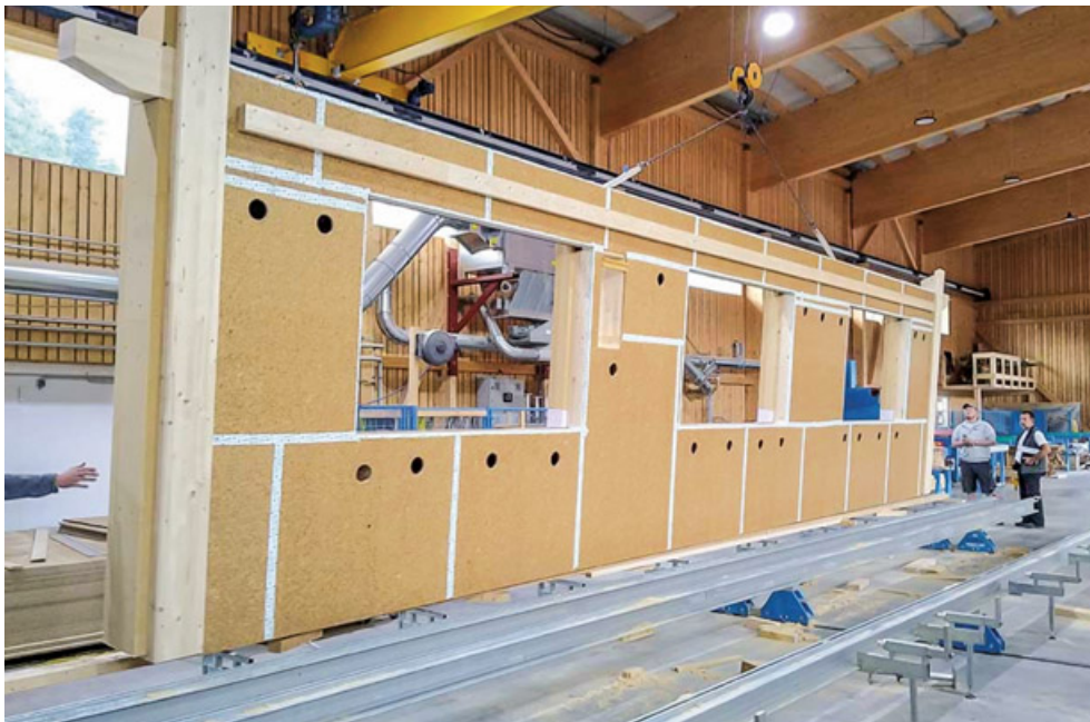
Ein hoher Grad an Vorfertigung sichert eine rasche Realisierung des Bauvorhabens.
