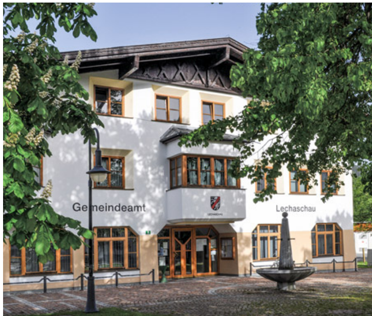
Das Gemeindeamt Lechaschau wird derzeit saniert.
