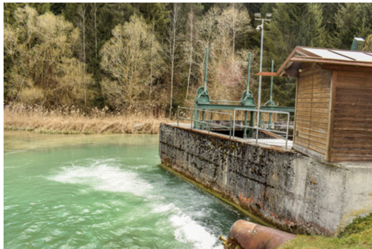
Der Stausee beim Kraftwerk der Stadtwerke Imst sollte auch ein Retentionsbecken für den Hochwasserschutz sein. Einsprüche der Fischer verhindern derzeit dieses Vorhaben.
