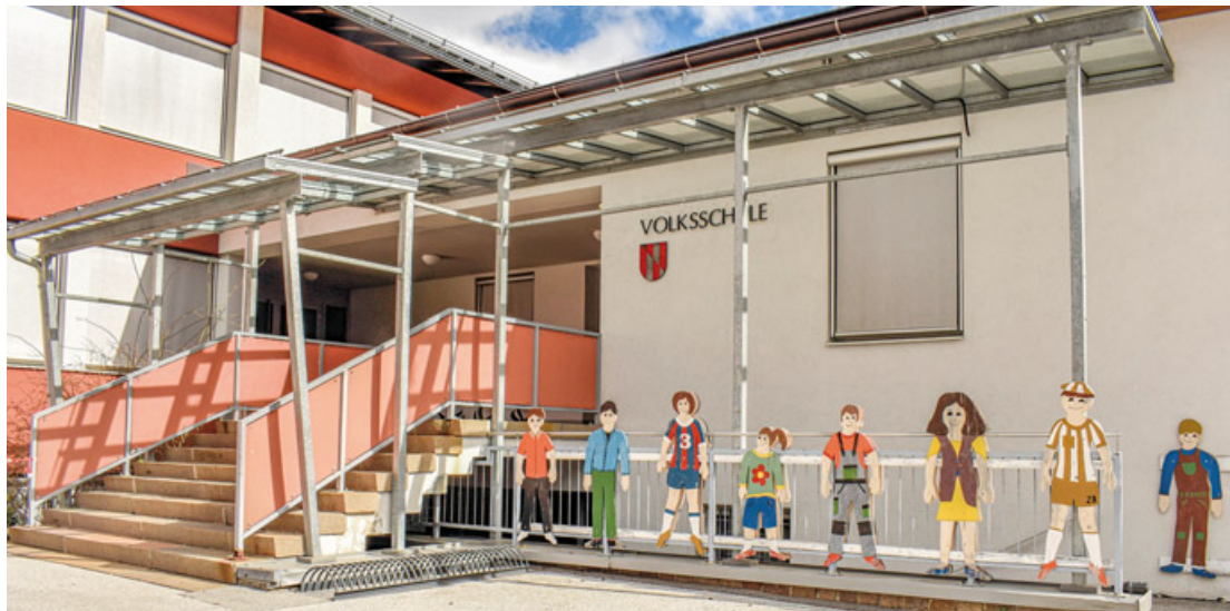
Die Volksschule Tarrenz muss dringend erweitert und saniert werden. Steigende Kinderzahlen, neue Formen des Unterrichts, die fehlende Barrierefreiheit und die teuren Energiekosten machen den Umbau notwendig. Foto: Eiter
