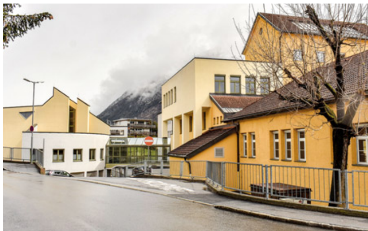
Die nächste große Baustelle: Das Schulzentrum in der Oberstadt soll mit einem Kostenaufwand von zirka 15 Millionen Euro saniert und ausgebaut werden.
