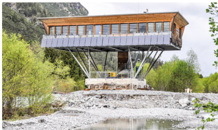
Wie ein „Technikdenkmal“ steht die Klimmbrücke bei Elmen ohne Zufahrten mittlen im „Letzten Wilden“, dem Lech.
