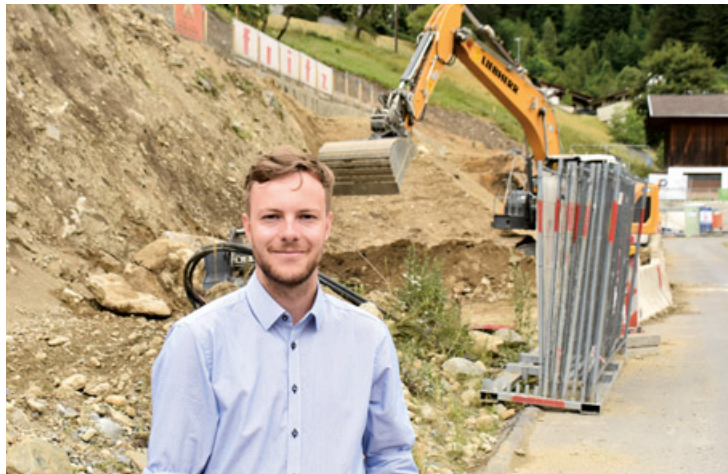
Eine erfreuliche Baustelle. Im Dorfkern von Jerzens wird derzeit eine Wohnanlage mit 36 Wohnungen gebaut, die auch an Mitarbeiter der heimischen Betriebe vergeben werden. Für junge Familien stehen zudem noch Grundstücksreserven zur Verfügung.
