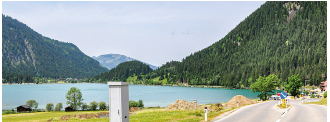
Unterhalb der Straße, nahe dem Haldensee, entsteht der neue Parkplatz.
