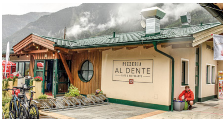
Beim Badesee wurde heuer ein neues Restaurant gebaut, das als Pizzeria betrie- ben wird. Die Gemeinde hat dafür 300.000 Euro investiert.
