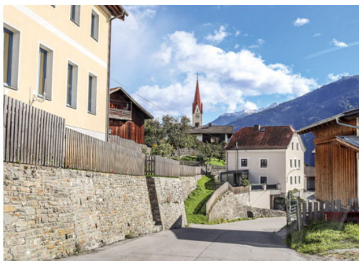
Im Ortsgebiet von Stanz stehen in diesem Jahr infrastrukturelle Maßnahmen an.
