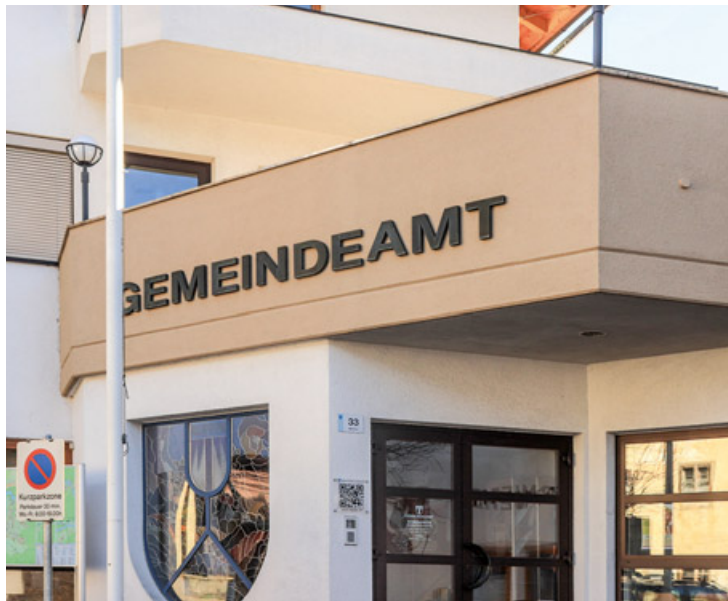
Das Gemeindehaus von Roppen soll zeitgemäß umgebaut und saniert werden.
