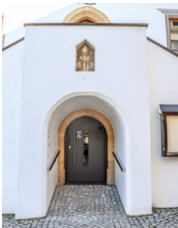
Beim Widum wurde eine öffentliche WC-Anlage errichtet. Fotos: Elisabeth Zangerl
