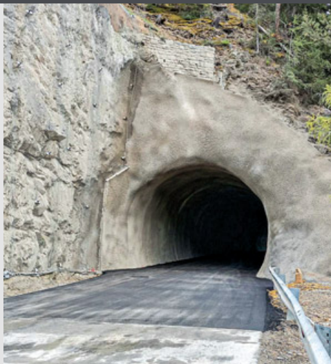
Nach vier Monaten Bauzeit konnte die Sanierung und Erweiterung der Bestandstunnel fertiggestellt werden.
