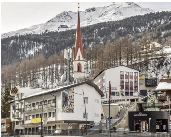
Kirche, Kraftwerk und ein modernes Schulzentrum. Mitten im Dorfzentrum von Sölden entsteht derzeit eine moderne Turnhalle samt Tiefgarage, Schulhof und neuen Räumen für die Musikschule.
