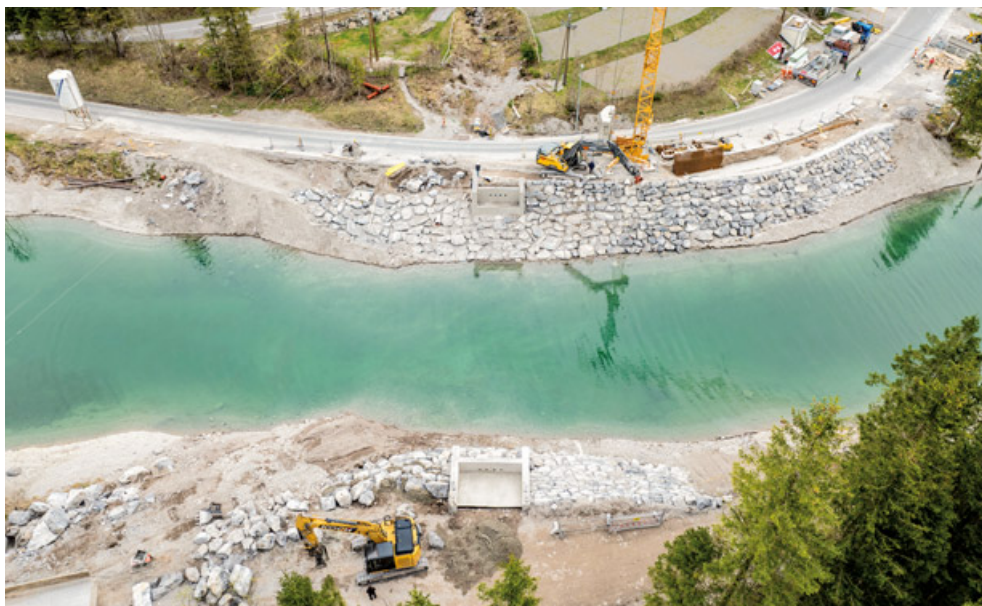
Über den Planseekanal wird die neue Seespitzbrücke gebaut.
