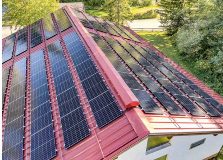
Die PV-Anlage auf dem Dach der Kläranlage Plansee wurde bei der Gemeinde Breitenwang installiert und hat eine Leistung von 42 kWp. Foto: Gemeinde Breitenwang
