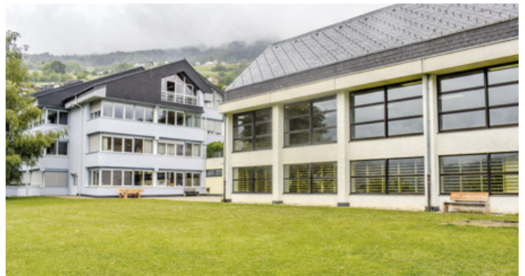
Auf der Wiese hinter der Mittelschule und unterhalb der bestehenden Turnhalle in Wenns wird demnächst ebenfalls ein eingezäunter Mini-Sportplatz samt Klettergarten und Weitsprunganlage errichtet.
