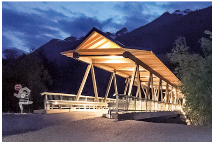
Die neue Klimmbrücke ist fertig und soll im August feierlich eingeweiht werden. Foto: Gemeinde Elmen
