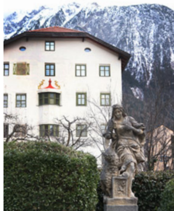
Der Turm in Oetz, der älteste profane Bau im Ötztal, prägt seit 650 Jahren das Dorfbild. Vor 20 Jahren wurde der Turm als Museum eröffnet. Fotos: Hirsch
