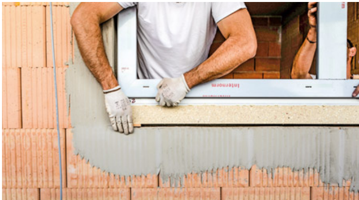
Sanieren lohnt sich aufgrund der aktuellen Förderlage heuer besonders.
