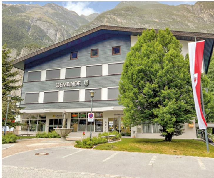
Das Gemeindehaus Schönwies wurde in diesem Jahr saniert – die Arbeiten wurden bereits abgeschlossen.
