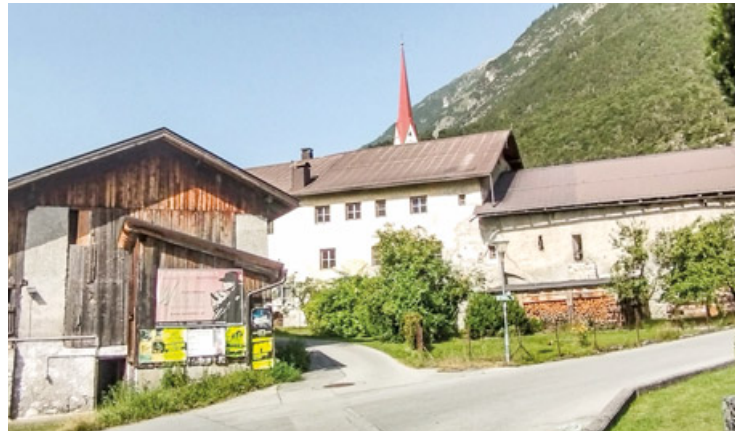
Die Bausubstanz einiger Häuser im Ortskern von Mils ist sanierungsbedürftig. Die Gemeinde will diesen Leerstand jetzt nützen, um sensibel Revitalisierungen zu starten. Beim alten Postmeisterhaus soll ein Musterprojekt entstehen. Foto: Eiter
