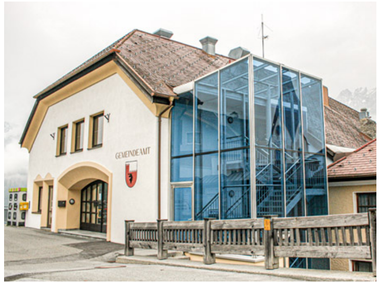
Das neue Gemeindehaus beschäftigt in finanzieller Hinsicht nur mehr das Budget 2024 und ist dann abgeschlossen.
