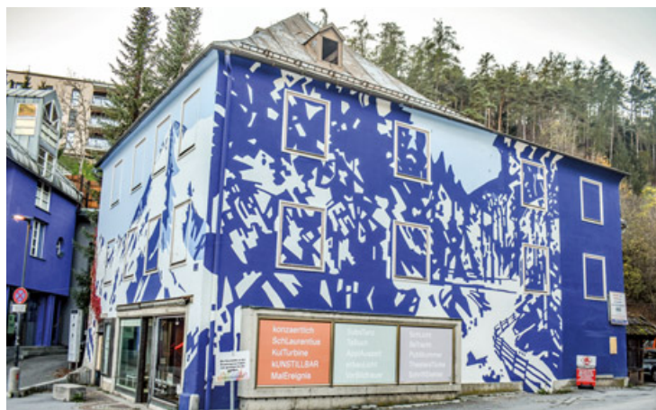
Das ehemals als Kleidergeschäft geführte Würtenbergerhaus soll saniert werden und künftig dem Tourismusverband als zentrales Bürogebäude dienen.
