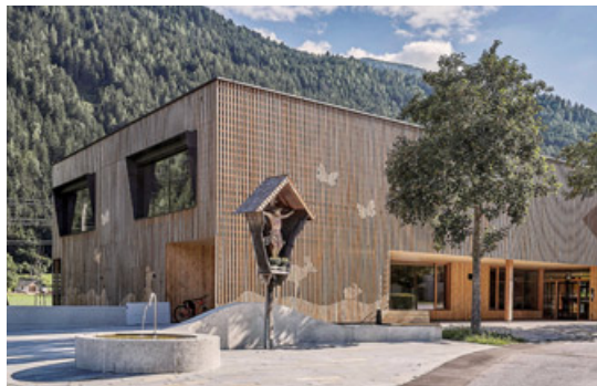
Die Kombination aus großen Fenstern und der konsequente Einsatz von Holz im Kindergarten Silz.
