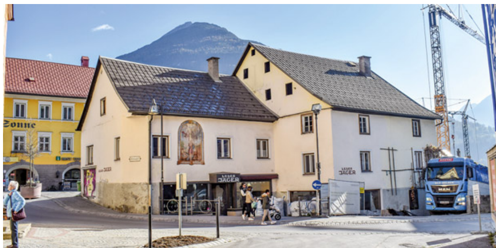
Das denkmalgeschützte Haus der mittlerweile geschlossenen Firma Leder Jäger wird stilgerecht saniert und einer neuen Bestimmung zugeführt.
