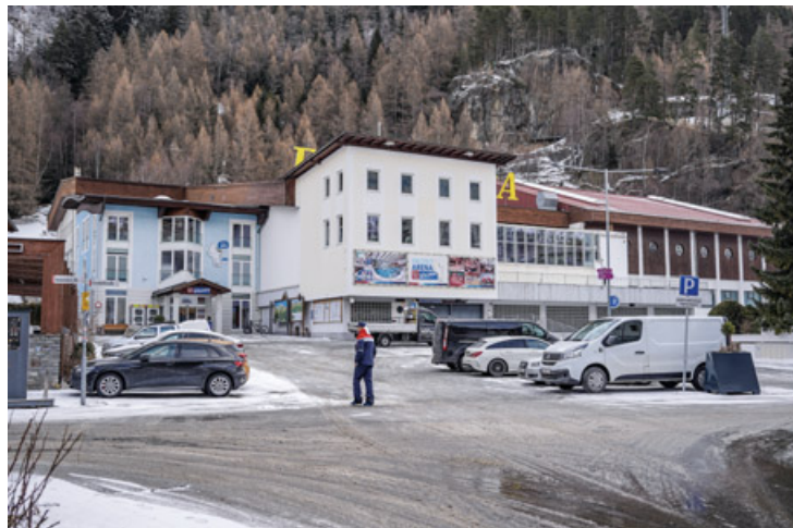
Die Freizeit Arena Sölden soll nach einer Sanierung in naher Zukunft wieder in neuem Glanze erstrahlen. Aktuell ist ein Fachexperten-Team mit der Überprüfung der Bausubstanz des Gebäudes befasst.
