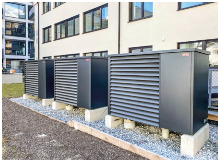
Multitalent unter den Heizsystemen – die Wärmepumpe kann Gebäude nicht nur heizen, sondern sorgt auch für Abkühlung an heißen Tagen. Foto: Energieagentur Tirol
