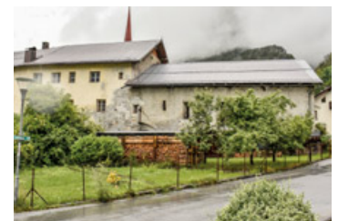
Das Postmeisterhaus soll revitalisiert und einer neuen Bestimmung zugeführt werden. Fotos: Eiter
