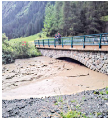
Die heurige Mure oberhalb von Neurur hat Kosten von 350.000 Euro verursacht.
