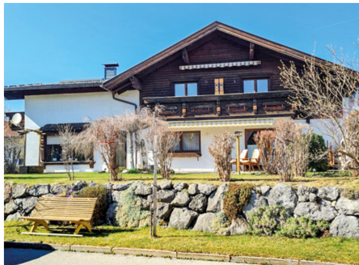
Das Haus vor dem Umbau.
