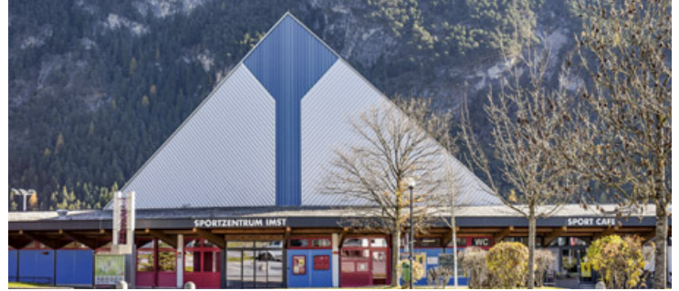
Das Imster Sportzentrum gehört zu den attraktivsten im Lande. Die Erneuerung der Anlagen wird in nächster Zukunft das Stadtbudget stark belasten. Fotos: Eiter
