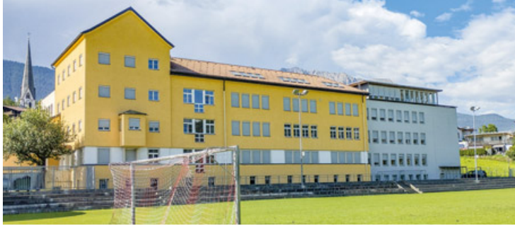
Die Schule in der Imster Oberstadt muss saniert werden. Die Projektkosten von 36 Millionen Euro sind im Moment aber nicht finanzierbar.
