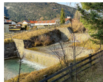
Die Stufen im Becken des Gaisbachs werden im Rahmen eines größeren Sanierungsprojekts nächstes Jahr entfernt.
