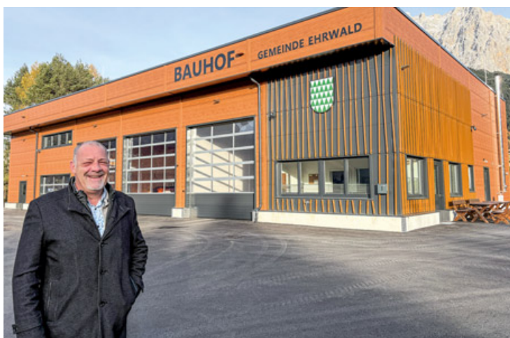
Bürgermeister Markus Köck zeigt sich mit dem Neubau des Bauhofs mehr als zufrieden.
