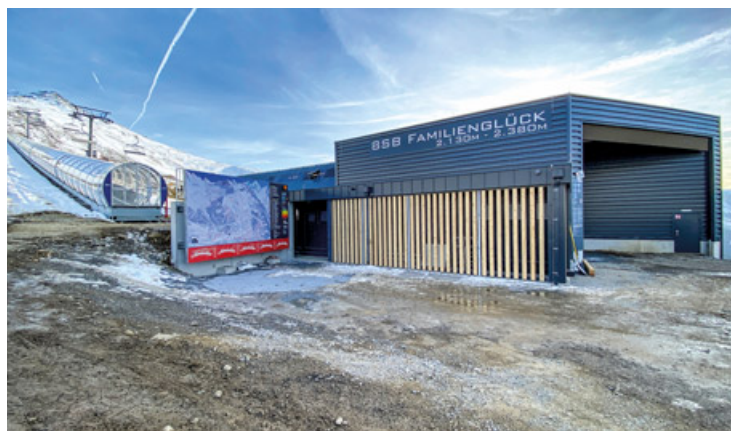
Ebenso beinhaltet das Gesamtprojekt ein 150 Meter langes, überdachtes Förderband. Foto: Angelo Jantscher/Bergbahnen See
