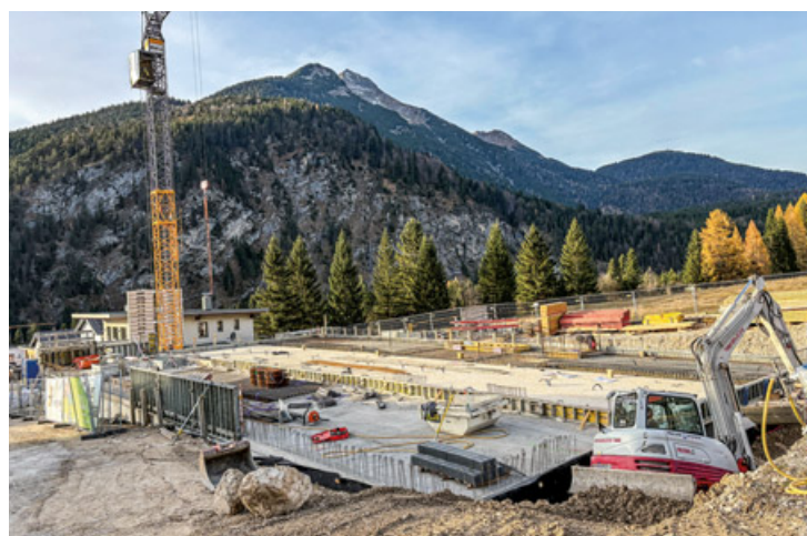
Für das Wohnbauprojekt der Tiroler Wohnbau ist die Tiefgarage bereits fertiggestellt.
