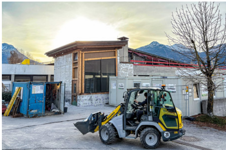
Beim Schwimmbad schreiten die Arbeiten voran, inzwischen ist ein Großteil des Abbaus erfolgt.
