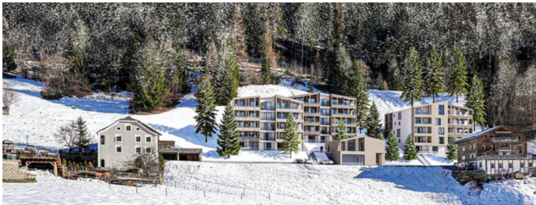
Die Neue Heimat Tirol plant in der Kirchstraße in See die Errichtung einer Passivwohnanlage mit 18 Mietwohnungen und 50 Dienstnehmerwohnungen. Mit dem Bau soll 2026 begonnen werden.
