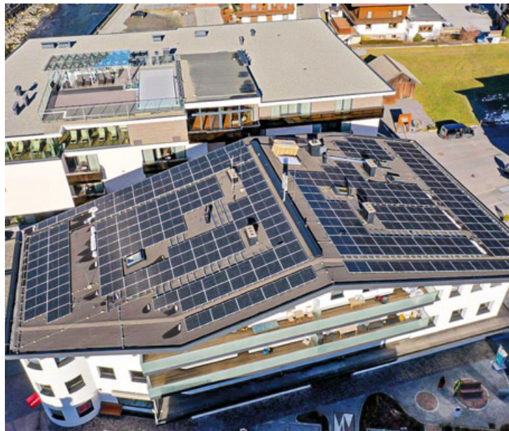
Sölden setzt auf Energie- und Klimaschutz und wurde dafür mit zwei „e“ ausgezeichnet. Die Gemeinde zeigt besonderes Engagement beim Ausbau von PV-Anlagen.
