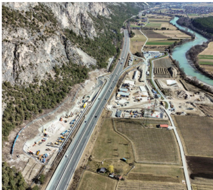
Die Ausmaße der Baustelle in Haiming für das Ausleitungskraftwerk Imst-Haiming sind gewaltig.
