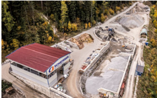
In der Sortieranlage Runser Au werden Wertstoffe fachgerecht aufbereitet.
