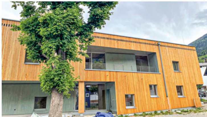
Der neue Kindergarten in der Urichstraße wird im Sommer fertig gestellt.
