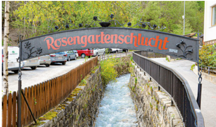
Die Rosengartenschlucht im Herzen der Stadt Imst ist ein Publikumsmagnet für etwa 120.000 Besucher. Die laufende Sanierung kostet der Stadt jährlich zwischen 50.000 und 70.000 Euro.
