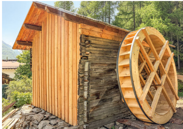
Die Mühle hat Thomas Riml saniert, das Wasserrad Ferdinand Plattner gebaut.
