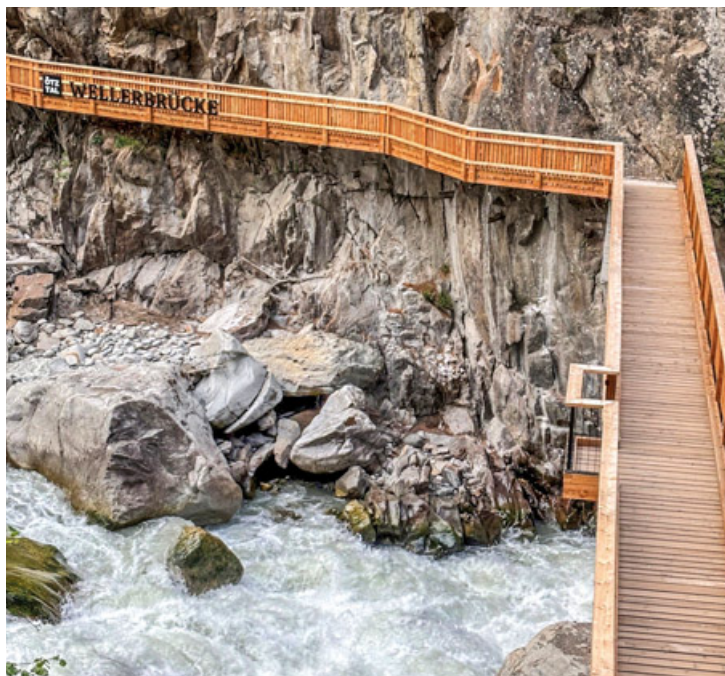
Die Sanierung der Wellerbrücke brachte funktionale Verbesserungen und ein Plus an Barrierefreiheit.
