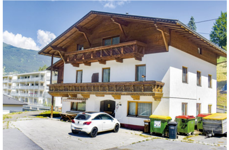
Mit dem Ankauf dieses Wohnhauses, das abgerissen werden soll, schuf die Gemeinde einen idealen Standort für das neue Einsatzzentrum. Foto: Eiter
