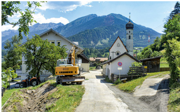
Im Ortsteil St. Margarethen werden derzeit im Bereich der kleinen Kirche das Kanal- und Leitungsnetz um zirka 400.000 Euro verlegt.
