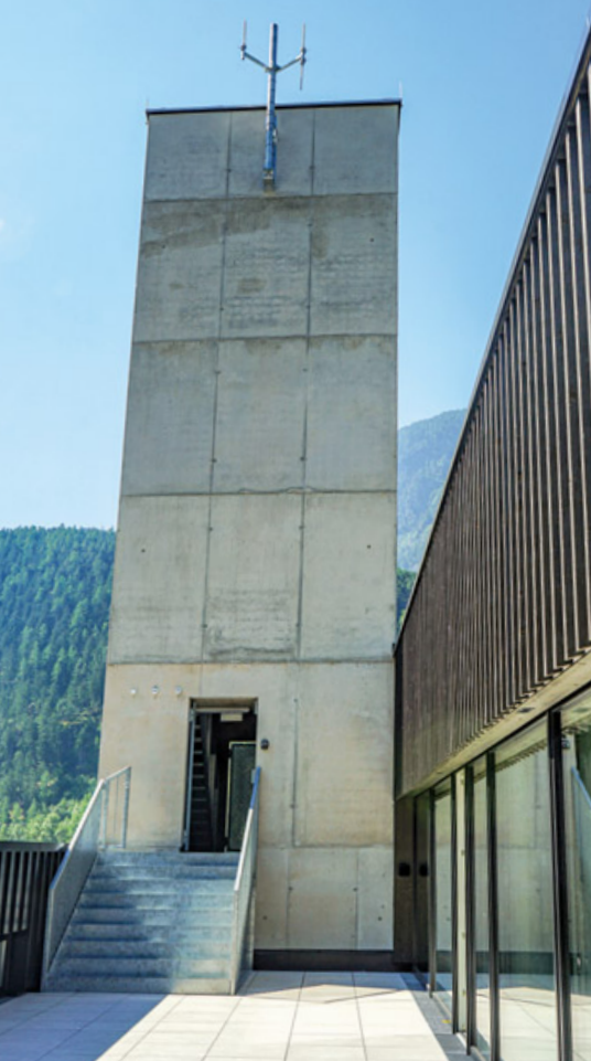
Der 18 Meter hohe Schlauchturm bietet zusätzlich die Möglichkeit von Abseil- oder Atemschutzübungen.
