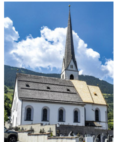
Die Sanierung des Kirchendaches wird am 8. August gefeiert.
