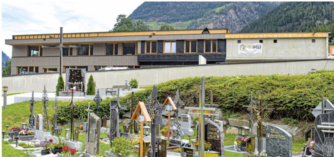
Direkt oberhalb des Friedhofes entsteht in Umhausen das neue Haus der Kinder. Das 8,5 Millionen Euro teure Projekt bietet für bis zu 188 Kinder moderne Betreuungsplätze. Im derzeit in Sanierung befindlichen Schulhaus werden für mehr als 200 Volks- und Mittelschüler sowie die Musikschule neue Klassenräume adaptiert.
