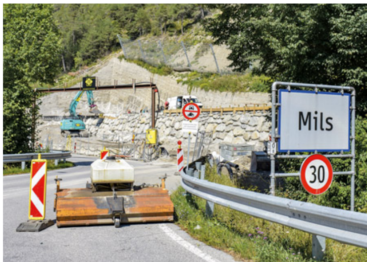
Die Sanierung des Milser Tunnels bietet nach Abschluss der Bauarbeiten auch einen wichtigen Steinschlagschutz für Teile des Milser Ortsgebietes.
