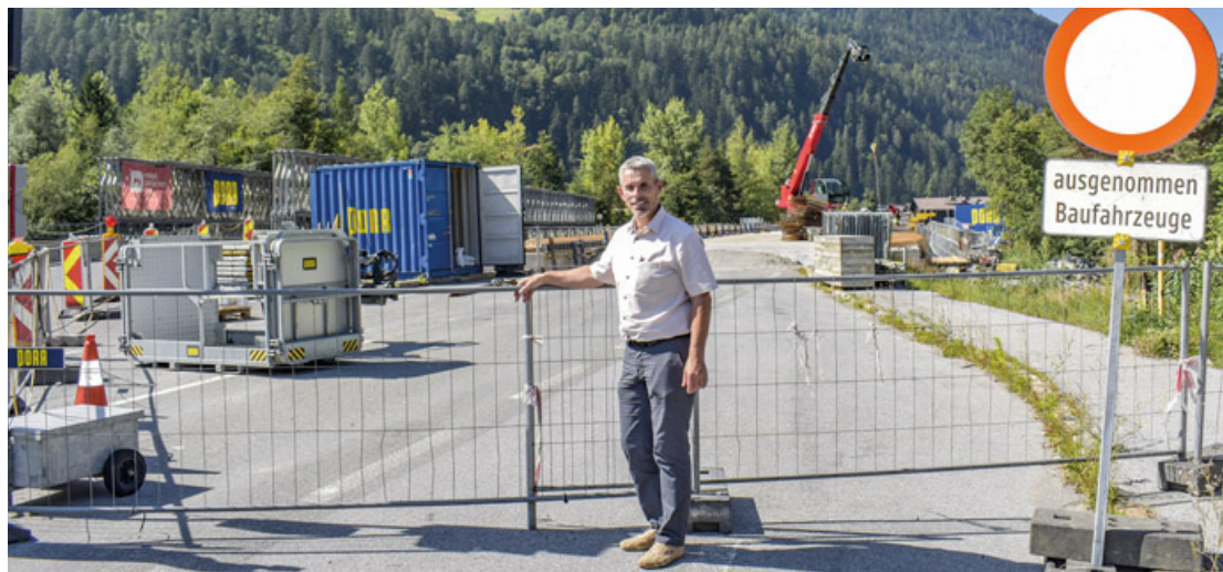
Bürgermeister Bernhard Schöpf – im Bild vor der Baustelle der neuen Innbrücke – freut sich über Millionenaufträge für die heimische Wirtschaft in seiner Gemeinde.
