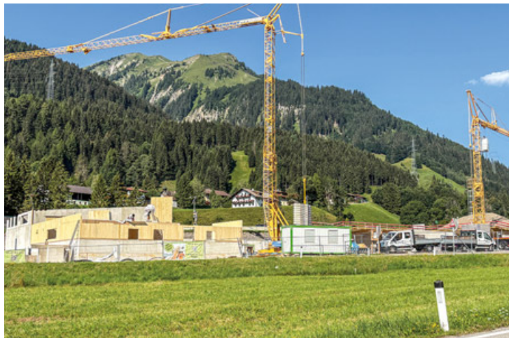
Als eine der ersten größeren Maßnahmen des Fernpasspakets wird derzeit in Lermoos die neue Straßenmeisterei errichtet. Foto: Dorn
