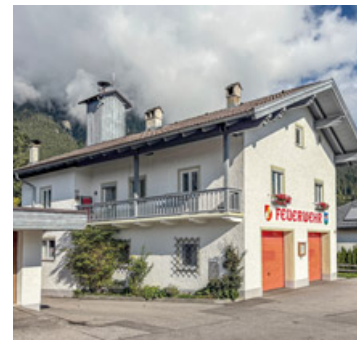
Das alte Feuerwehrhaus ist nicht mehr zeitgemäß und zu klein für den Fuhrpark der Florianijünger. Foto: Dorn
