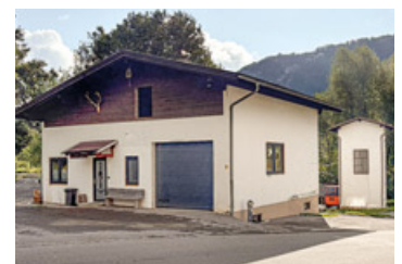
Mit viel Eigenregie wird dieses kleine Gebäude neben dem Gemeindeamt nun saniert. Foto: Dorn
