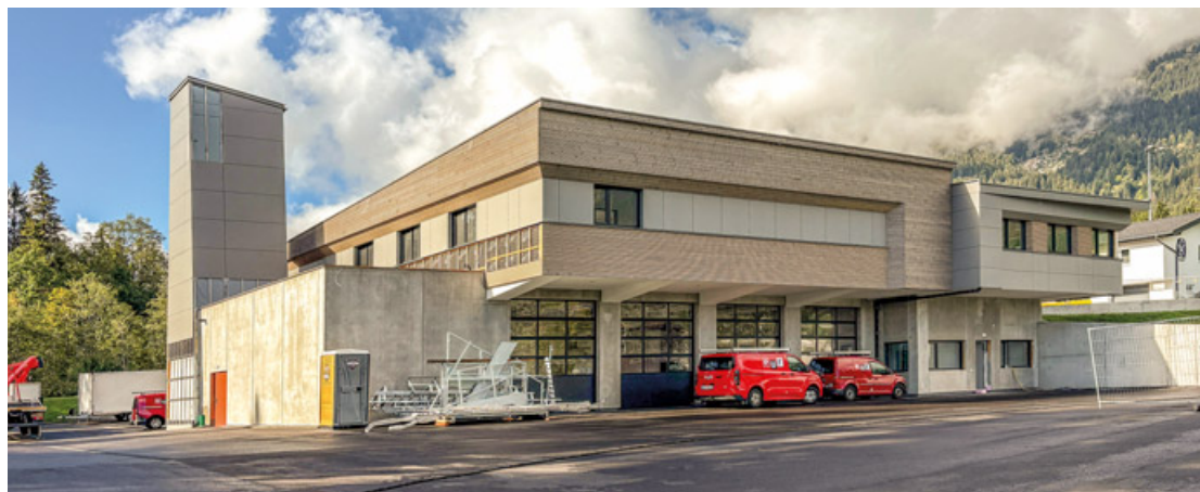
Das neue Mehrzweckgebäude der Gemeinde Wängle wird Mitte Oktober fertiggestellt. Die Einweihung wird nächstes Jahr erfolgen. Foto: Dorn
