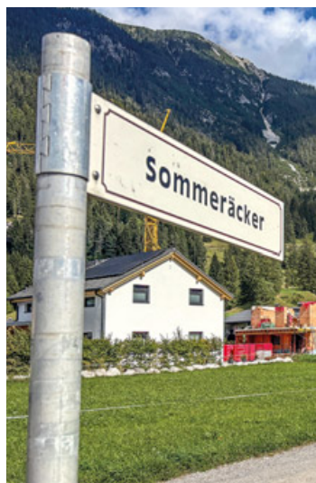
Die Zufahrt für die neuen Bauplätze am Sommeräcker ist fertiggestellt, die Asphaltierung muss warten. Fotos: Dorn
