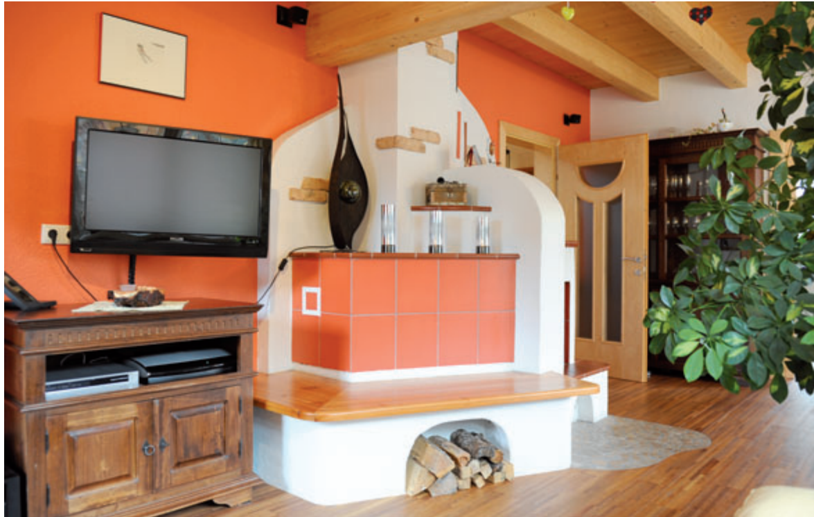
Der Kachelofen wurde zentral in das Haus gesetzt. Lässt man die Türe offen, dann heizt er auch das Stiegenhaus.
