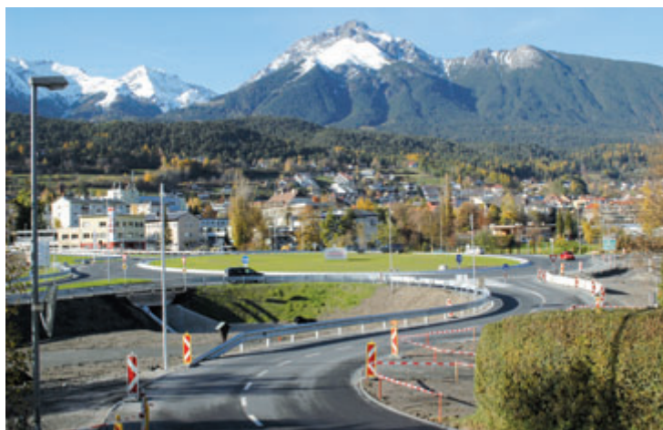
Sichtbares Zeichen der rasanten Entwicklung von Imst: Der neue Kreisverkehr mit Radweg, Fußgängerunterführung und neuem Parkplatz ist mit 80 Metern Durchmesser der größte Kreisverkehr Tirols.
