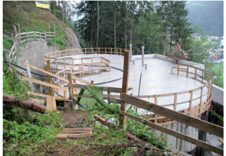
Abgeschlossen sind die Bauarbeiten beim Trinkwasserhochbehälter „Schalleranger“. Foto: Gemeinde Zams
