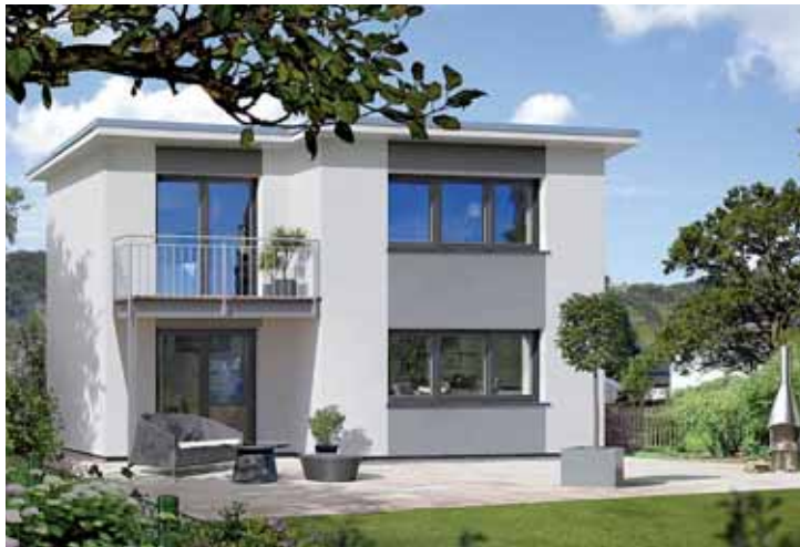
Pultdächer bieten den Vorteil, dass die oberste Geschoßfläche uneingeschränkt als Wohnraum nutzbar ist.
